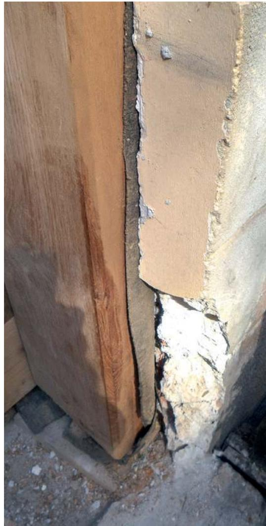
gangsbereich zum Blickfang macht. Bei der gezeigten Tür wurden einzelne Teile durch aufsteigende Feuchtigkeit stark geschädigt. Während der Restaurierung kam es deshalb besonders auf die richtige Wahl des Holzes und weitere präventive Maßnahmen an. Beides Voraussetzungen, um Schäden dieser Art in Zukunft weitgehend zu verhindern.
