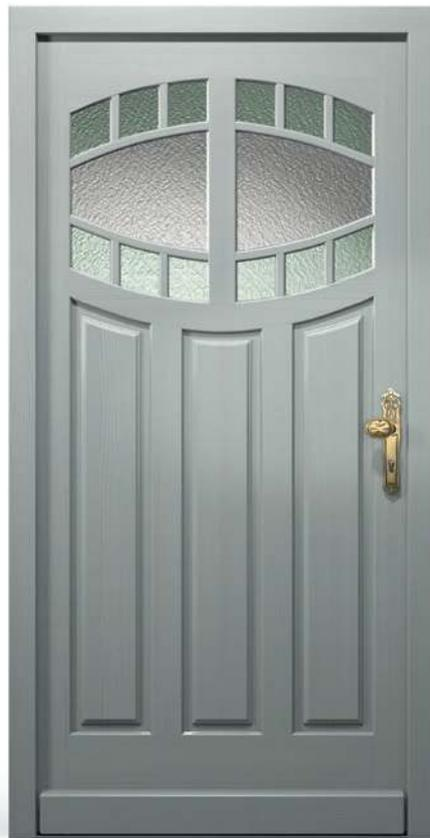
*Die bauzeitgemäße Garnitur mit Langschild und Knopf, aus massivem Messingguss nachgefertigt, wurde hier als Sicherheitsgarnitur ausgeführt.*
