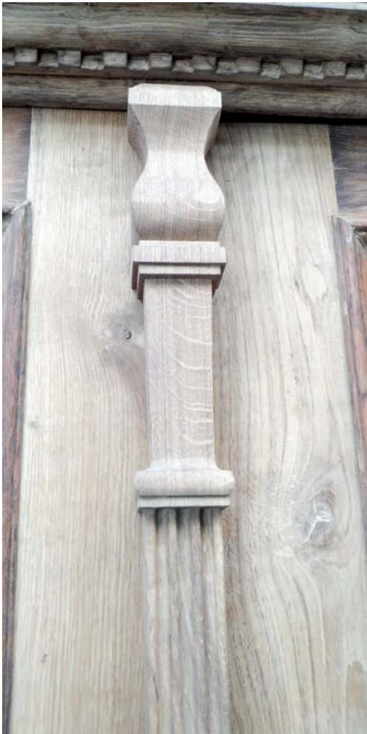
**BEI DER RESTAURIERUNG** von historischen Türen sind Fachkenntnis und Gespür gefragt. Besonders wenn, wie in diesem Beispiel, wichtige Elemente wie die Schlagleiste komplett fehlen. Die fehlenden Elemente werden individuell und nach vergleichbaren Vorbildern von Hand angefertigt und profiliert. Das Resultat ist eine harmonische Gesamtgestaltung, die auch diesen Ein-
