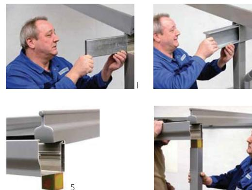
Nach dem gewählten System wird entweder das Fallrohr (1) oder ein Trägerprofil (2) mit verzinktem Stahl verwendet, um die Durchbiegung zu verhindern. Das Fallrohr muss fest am Trägerprofil befestigt sein. Eine Abdeckung mit Moosgummi (4) sorgt für dauerhafte Abdichtung. Besonders stabil ist die Verankerung der Rinne in der Wand. Das Fallrohr kann durch passende Aluminiumbleche (5) geschützt werden.
