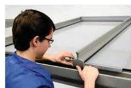
Erstaunlich viele Details: Die Dachträger mit den darauf sitzenden Glasleisten müssen besonders sorgfältig fixiert werden, damit die Dacheindeckung (Glas oder Stegplatten) sicher eingefasst werden und keine Verspannungen entstehen können (1). Passende Endstücke lassen die Details im Inneren „verschwinden“ und sorgen für ein elegantes Aussehen (2-3).
