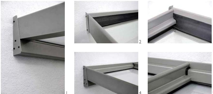
Die Dachträger müssen fest und sicher mit dem Wandanschlussprofil verbunden werden (1). Besonderes Augenmerk liegt auf einer guten Abdichtung, damit Regenwasser nicht in die Konstruktion eindringen kann (2 und 3). Nach dem Seitenträger folgen die Mittelträger in statisch ermittelten Abständen, damit die Dacheindeckung sicher getragen werden kann (4). Abbildung 5 zeigt den fachgerechten Anschluss eines Mittel-Dachträgers an den Wandanschluss.
